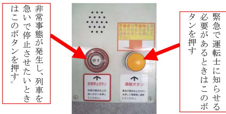
写真 車内非常停止装置及び通報装置
